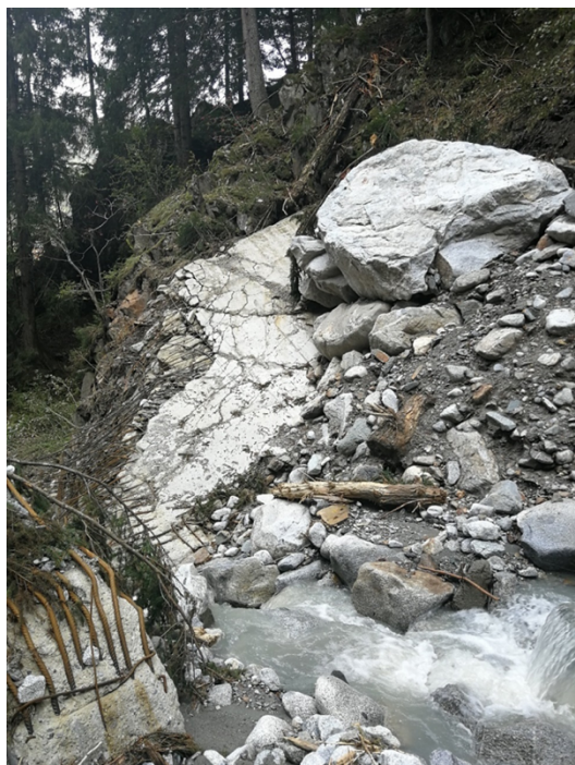
La briglia filtrante sul Torrente Vallaro (BS) distrutta dalla colata detritica del 28.8.2020
